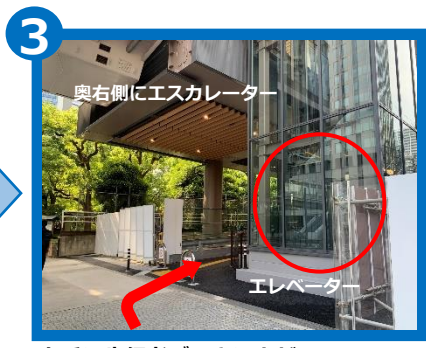
3 奥右側にエスカレーター 右手に歩行者デッキに上がるエレベーターとエスカレーターがあります。東京ポートシティ竹芝オフィスタワーの3階につながっています。
