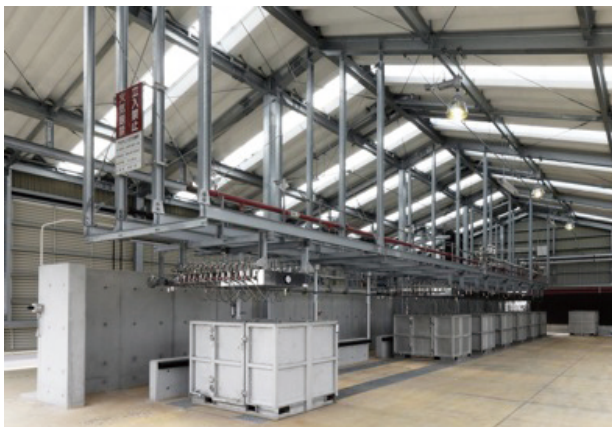
(完成したアセチレン充てん工場内部)
