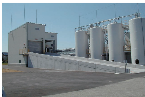
新設した湿式による発生工場
