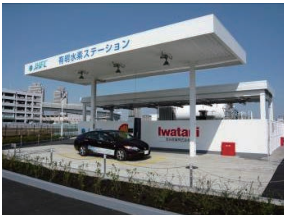
現行法令下の液体水素ステーション
