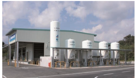
総合ガス供給センターの外観
