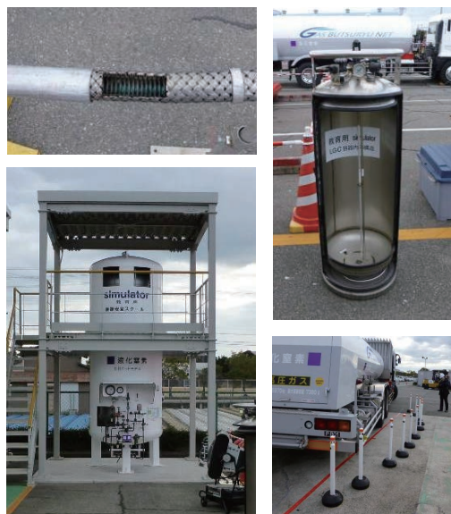
（左上から時計回りで） フレキシホースカットモデル、LOXカットモデル、 ローリのオーバーハング、CEカットモデル
