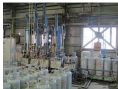
復旧した容器再検査工場
