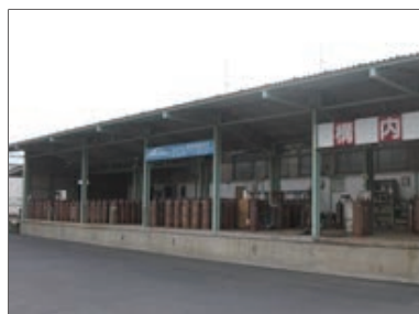
復旧した容器置場
