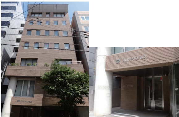
事務所ビル外観
