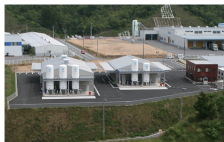
安来ガスセンター
