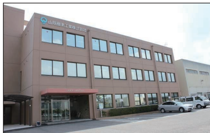
本社内屋 外観
