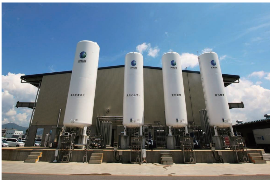
一般ガス充填棟（正面）
