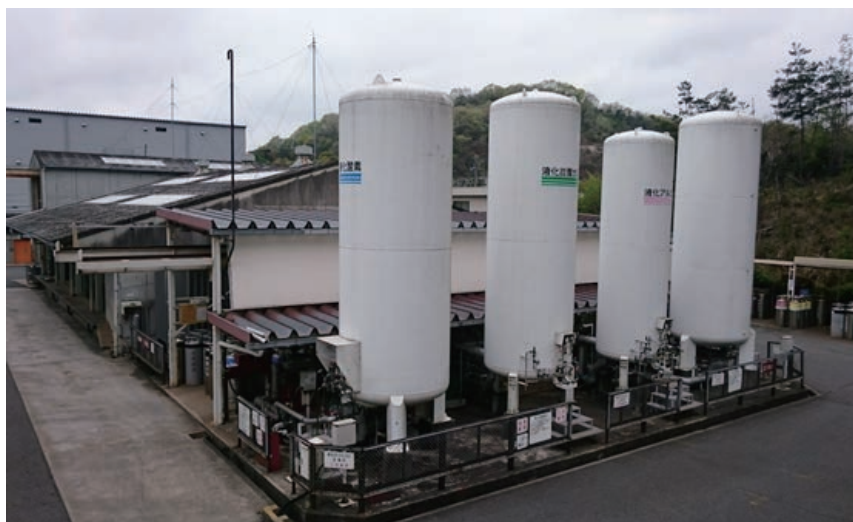
姫路工場全景
