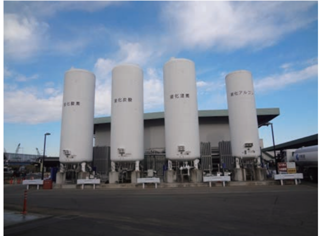
CEヤード全景
