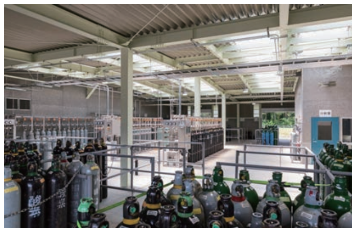
新工場充填作業場
