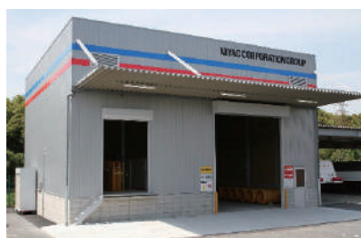
高圧ガス容器置場
