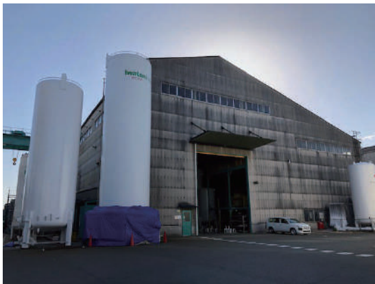
本社工場（一部）
