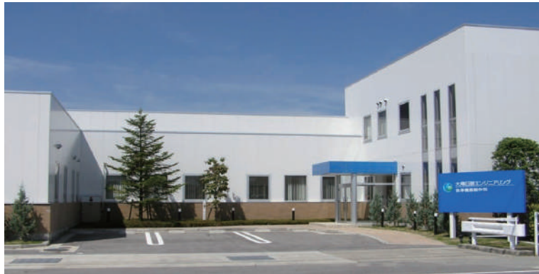
会津機器製作所外観
