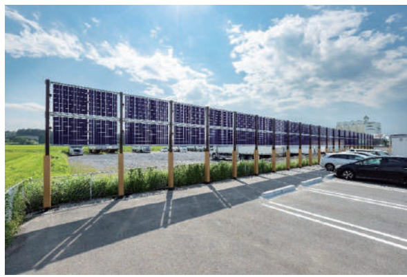
垂直ソーラー発電システムを設置
