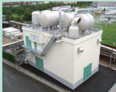
PSA式酸素ガス発生装置
