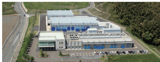
HyTReC Hydrogen Energy Test and Research Center 水素エネルギー製品研究試験センター
